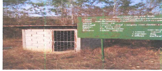
28. ห้องควบคุมระบบไฟฟ้า โครงการประปาหมู่บ้าน
